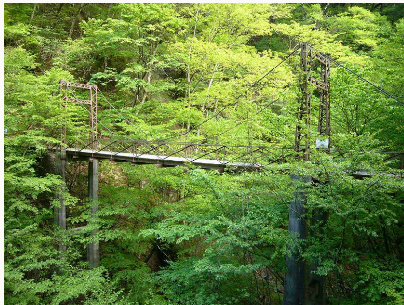
藤尾橋全景。トラス模様の欄干がお洒落である。
