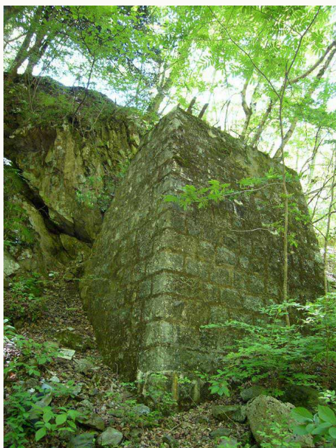
泉水谷左岸には橋脚が一本残されていた。さすがに空積みではなく、モルタルで固められた丁寧な布積みの石垣である。これも船越橋同様、大正頃に改築されたのだろうか。
