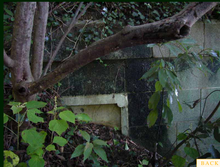
2007年7月25日の城東隧道西口。ここを掘り返すことになる。
