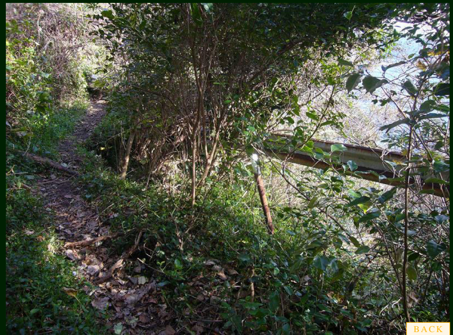
装備を整えていざ半年ぶりの震災廃道へ。序盤は釣り人のつけた踏み跡が鮮明である。
