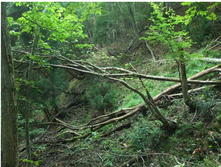
隧道前の車道から旧車道側を見る。崩れてしまっているが道跡が見出せる（補助線参照）
