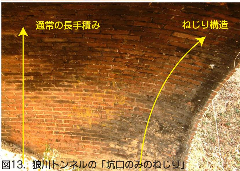
図13. 狼川トンネルの「坑口のみねじり」
