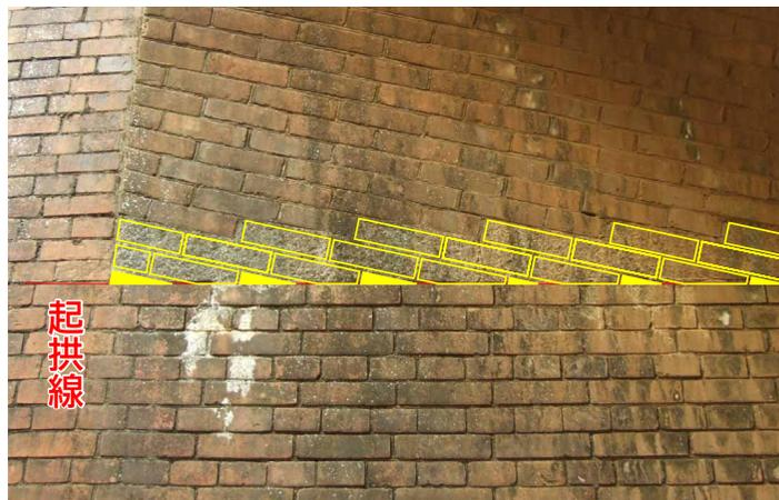
図16. 門の前橋梁の迫受石を煉瓦にすると…黄色で塗りつぶしたような小さな煉瓦が必要になるのでかえって面倒。圧力で割れるおそれもある
