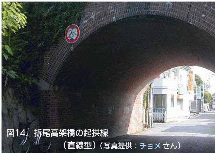
図14. 折尾高架橋の起拱線
