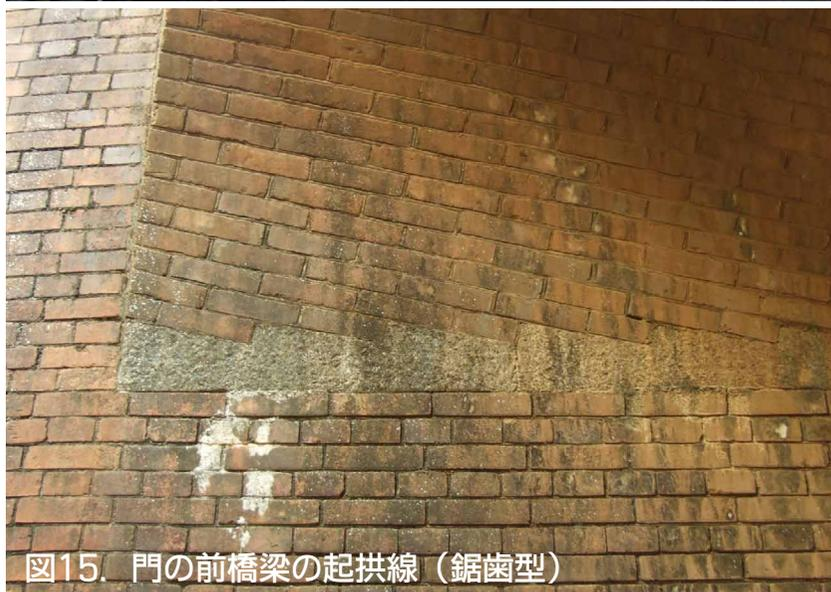
図15. 門の前橋梁の起拱線 (鋸歯型)
