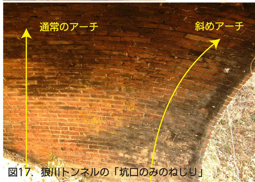
図17. 狼川トンネルの「坑口のみねじり」
