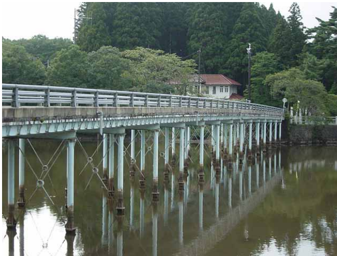
今日の十六橋。奥に「戸ノ口水門監守所」の建物が保存されている
