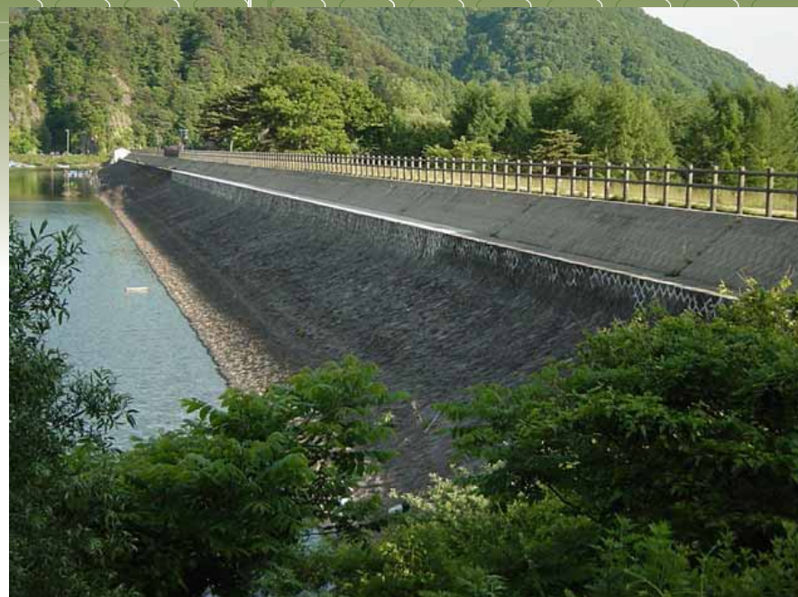
秋元湖西岸に建設された堰堤。奥に水門が見える
