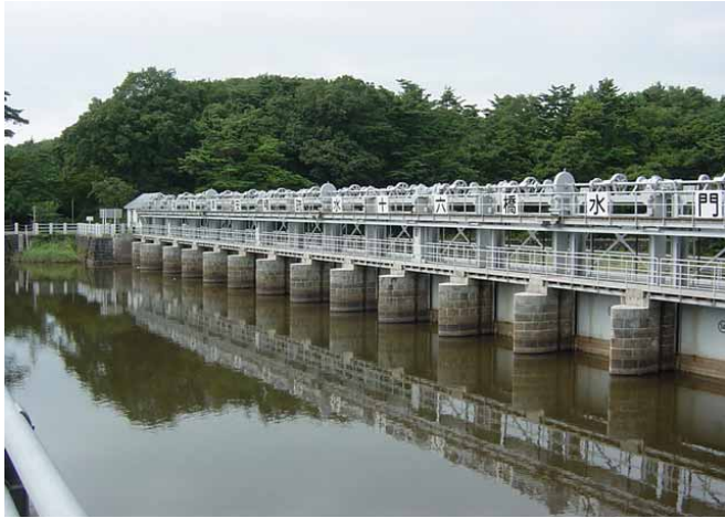
安積疎水十六橋水門
